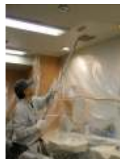
塗膜が厚くならないように塗装する
