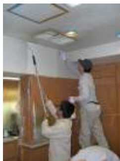
スーパー・テラ施工
