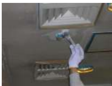
角や養生した回りなど、ローラーで塗れない所をハケで塗装
